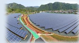
愛川太陽光発電所
